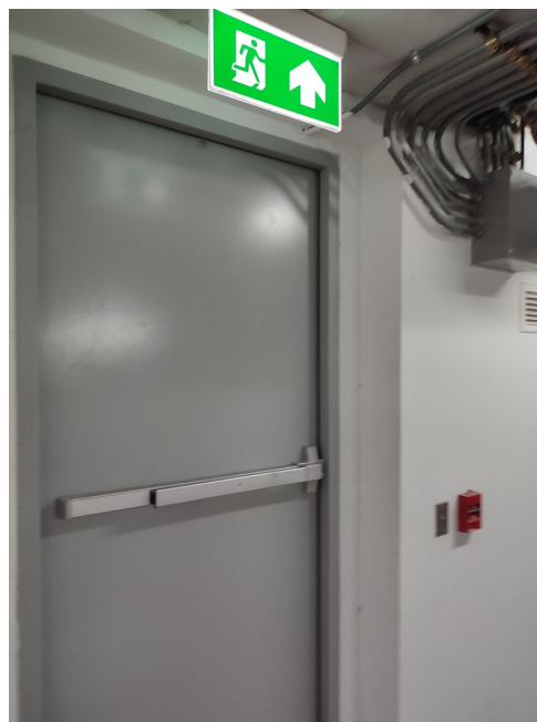
ภาพที่ 5-31 ประตูหนีไฟแบบ Re-Entry
