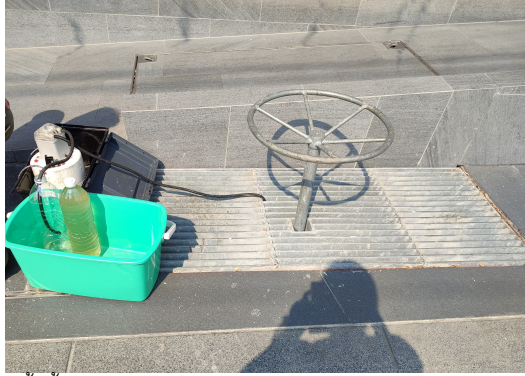
ภาพที่ 5-14 บ่อพักน้ำที่มีตะแกรงดักขยะ และ Stop Log ไม่มีขยะอุดตันสามารถระบายน้ำได้ดี
